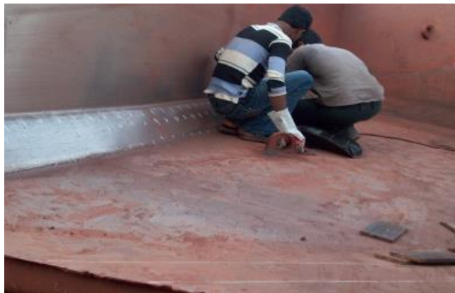
Lấy dấu khu vực lắp đặt
