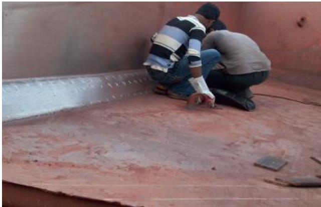
Lấy dấu khu vực lắp đặt
